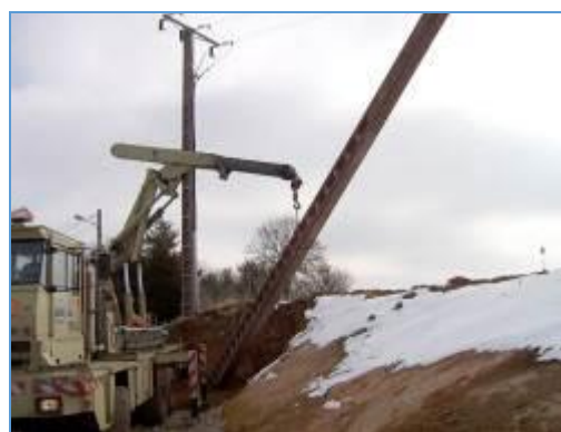
Dépose du poteau béton avec le lève-poteau
