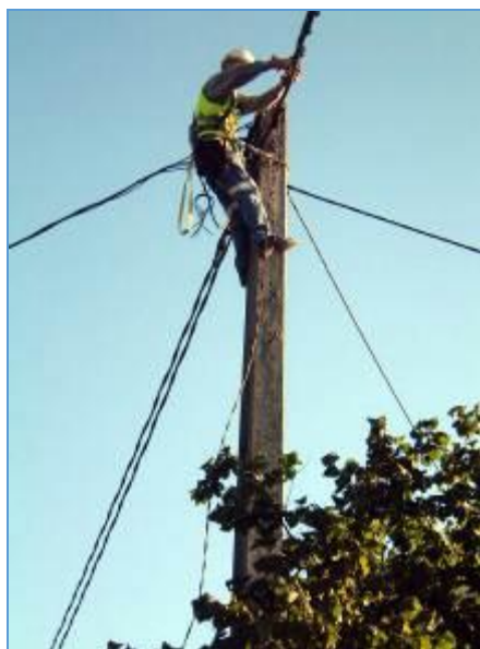
Dépose des branchements aériens avant dépose du réseau à la nacelle
